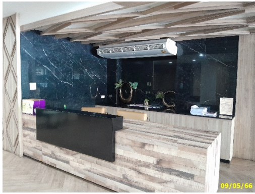
ระบบปรับอากาศแยกส่วน (Split Type Air Conditioning Unit)
