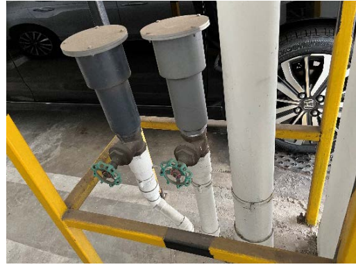
ท่อเติมอากาศระบบบำบัด
