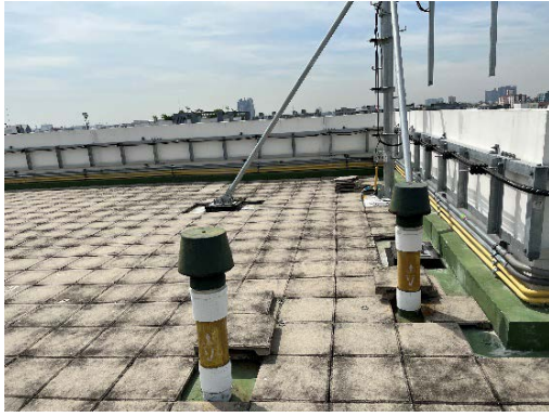
ท่อกำจัดละอองน้ำเสีย (Aerosol)
