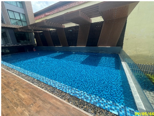
โครงสร้างสระว่ายน้ำ และรางระบายน้ำล้น
